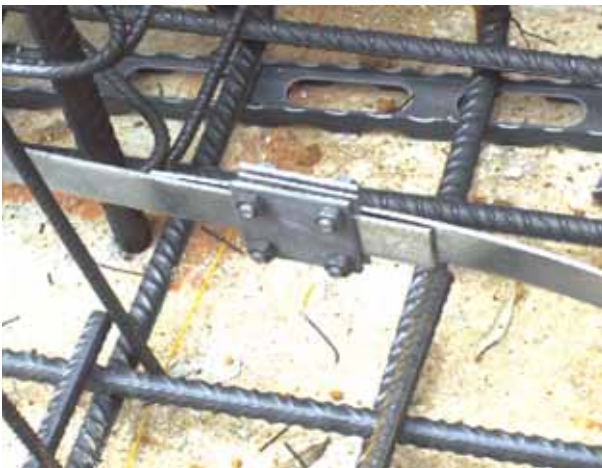
Βήμα 14. Την επιμήκυνση ή διακλάδωση των ταινιών την πραγματοποιούμε με σφιγκτήρες κωδικού ΕΛΕΜΚΟ 6201833.
