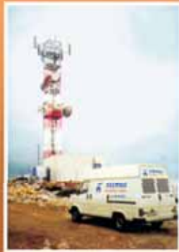
Σταθμούς Κινητής Τηλεφωνίας Mobile and Stationary Telecom facilities
