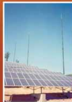
Φωτοβολταϊκά Συστήματα Photovoltaic Solar Systems
