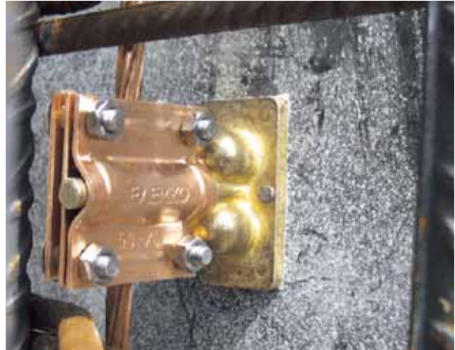
Βήμα 21. Συνδέουμε τον αγωγό γείωσης με τον ακροδέκτη με σφιγκτήρα κωδικού ΕΛΕΜΚΟ 6221837, για αγωγούς γείωσης 16 ÷ 35mm 2 και 6221810, για αγωγούς 50 ÷ 70mm 2 και Ø8mm ή Ø10mm.
