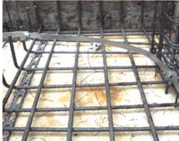
Βήμα 13. Αποφεύγουμε ταγωνιάσματα της ταινίας και σχηματίζουμε ανοιχτές καμπύλες. Στις θέσεις αυτές στηρίζουμε τον υπόλοιπο οπλισμό με δύο σφιγκτήρες, έναν πριν και ένα μετά την καμπύλη.
