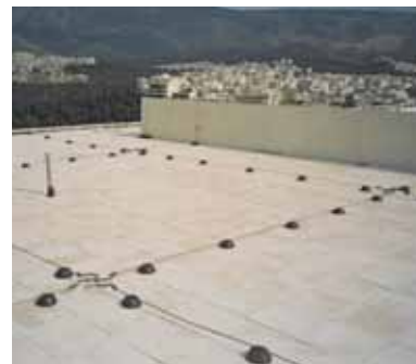
Πλέγματα αγωγών Meshed conductors
