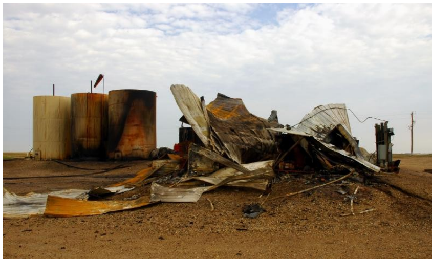
Εικόνα 1: Καταστροφές από ανάφλεξη λόγω σπινθήρα που δημιουργήθηκε από στατικό ηλεκτρισμό
